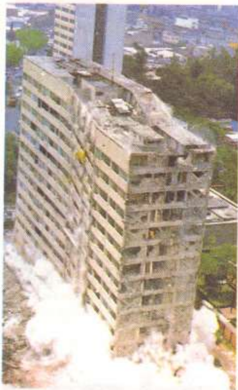
Figura 234. Técnicos mexicanos especializados demolieron el edificio en cuestión de 10 segundos.
