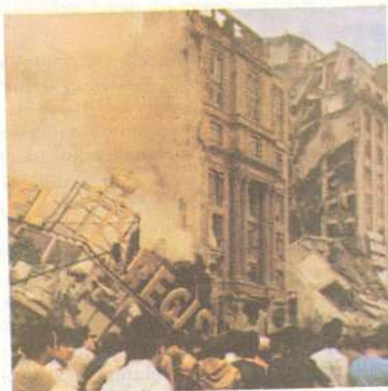
Figura 207. Después del primer sismo del 19 de septiembre de 1985 sólo se observaba destrucción y fuego. Los curiosos se acercaban a las ruinas y a los escombros sin saber que se produciría un segundo sismo al día siguiente.
