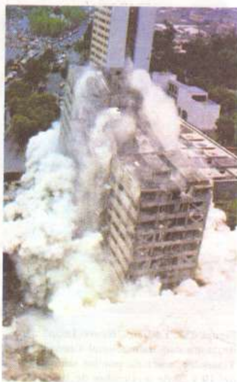
Figura 235. Para derribar el "Nuevo León" bastaron 131 kilogramos de explosivo plástico.
