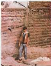
Figura 113. Abocanzamiento con características onduladas, con suspensión incompleta, ofreciendo: (1) un lado de brida hacia el exterior y (2) atado a otras varillas adyacentes del muro, (3) tablero y losas para el encofrado.
