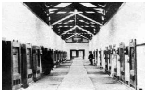
Imagen No 2. Estructura interna de un penal. 24
