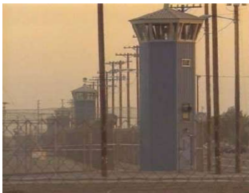
Imagen No 1. Estructura externa de un penal. 21
