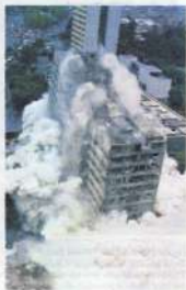
Figura 235. Para derribar el "Nuestro León" bastaron 131 kilogramos de explosivo plástico.
