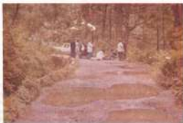
Figura 66. Panorámica del lugar de los hechos. Brecha utilizada como camino para peatones, de 5 metros de ancho, con trayectoria ascendente, situada en el cuarto dinamo de Contreras, D.F.
