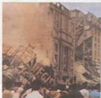
Figura 207. Después del primer sismo del 19 de septiembre de 1985 sólo se observaba destrucción y fuego. Los curiosos se acercaban a las ruinas y a los escombros sin saber que se produciría un segundo sismo al día siguiente.
