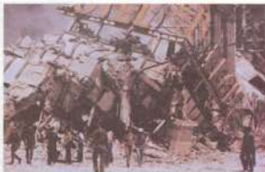
Figura 208. Al producirse el segundo sismo el día 20 de septiembre de 1985 se generó mayor destrucción de casas y edificios, pero por fortuna no fueron de mucha consideración las pérdidas humanas. Maquinarios, voluntarios y elementos de la Armada de México procedieron al rescate de personas y valores en sus áreas de responsabilidad.
