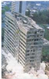
Figura 234. Técnicos mexicanos especializados demolieron el edificio en cuestión de 10 segundos.
