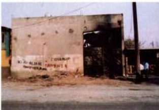
Figura 7.27. Daños causados por explosión, caso 2
