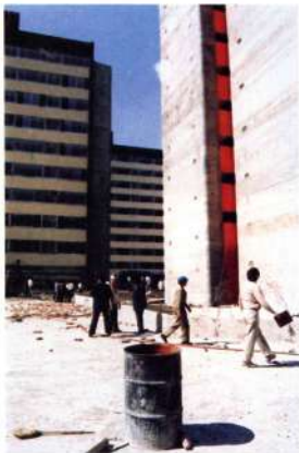
Figura 7.20. Daños causados por explosión, caso 1
