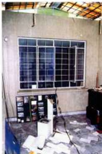
B. Vista general de la cocina en detalle.
