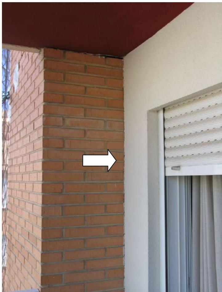
**Foto nº 14.-** Otro detalle del movimiento de la fachada en el rincón de la terraza del piso
