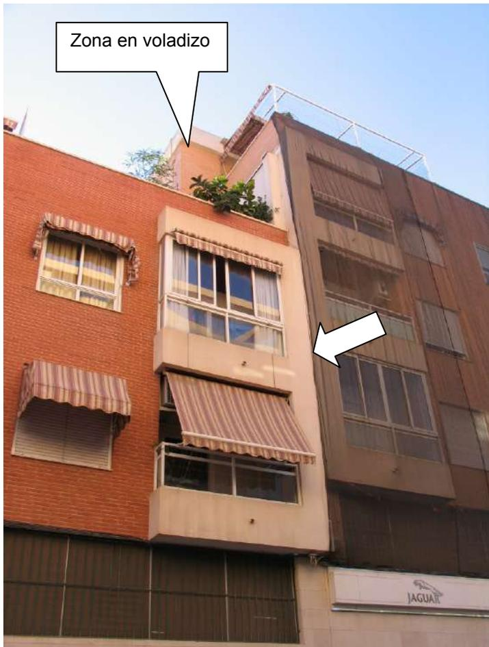
**Foto nº 24.-** Posición de la junta de dilatación estructural del edificio y de la zona en voladizo del Bloque B sobre el Bloque A. Fachada Calle
