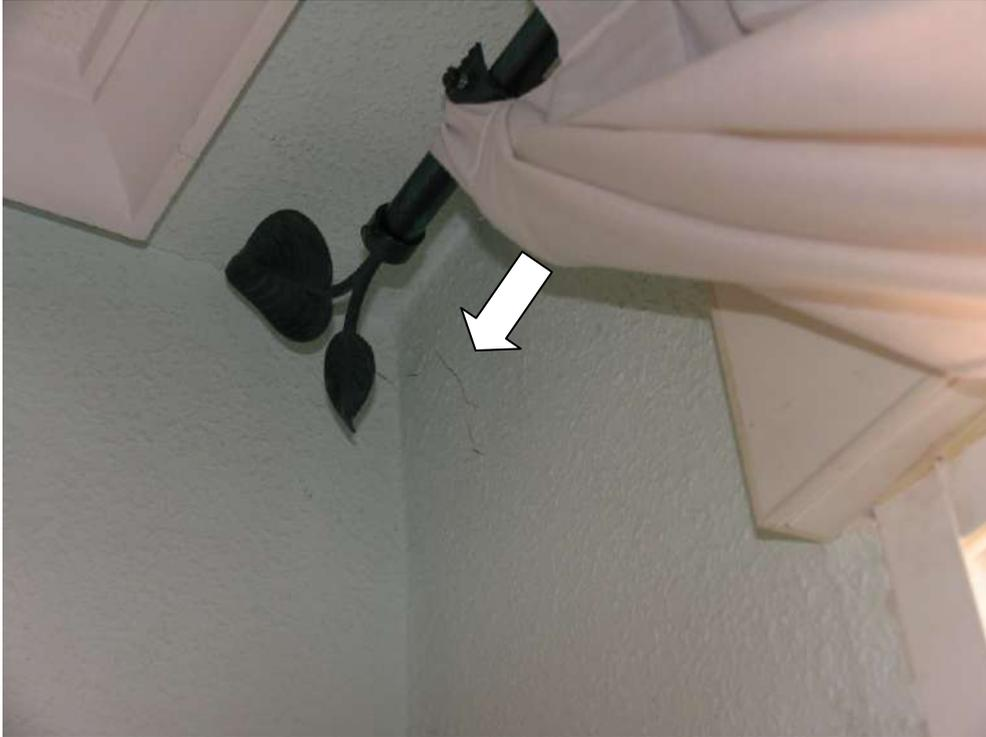
**Foto nº 17.-** Aqrietamientos en el interior del salón comedor del piso 3ºF.
