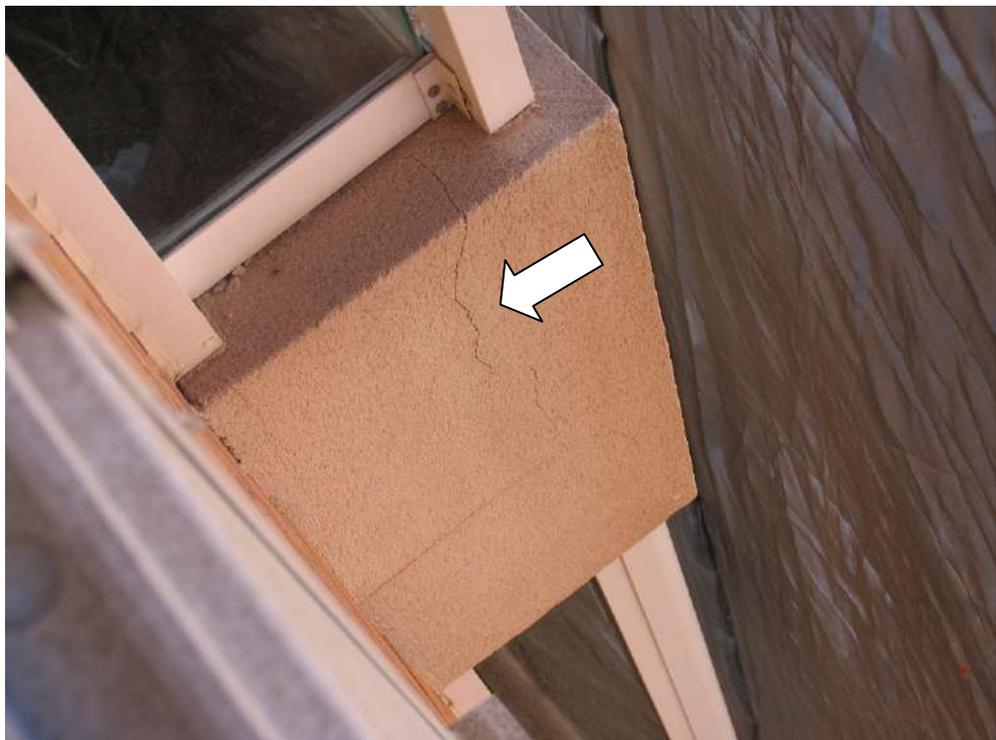
**Foto nº 16.-** Agrietamientos en el antepecho de la terraza del piso 3ºF.
