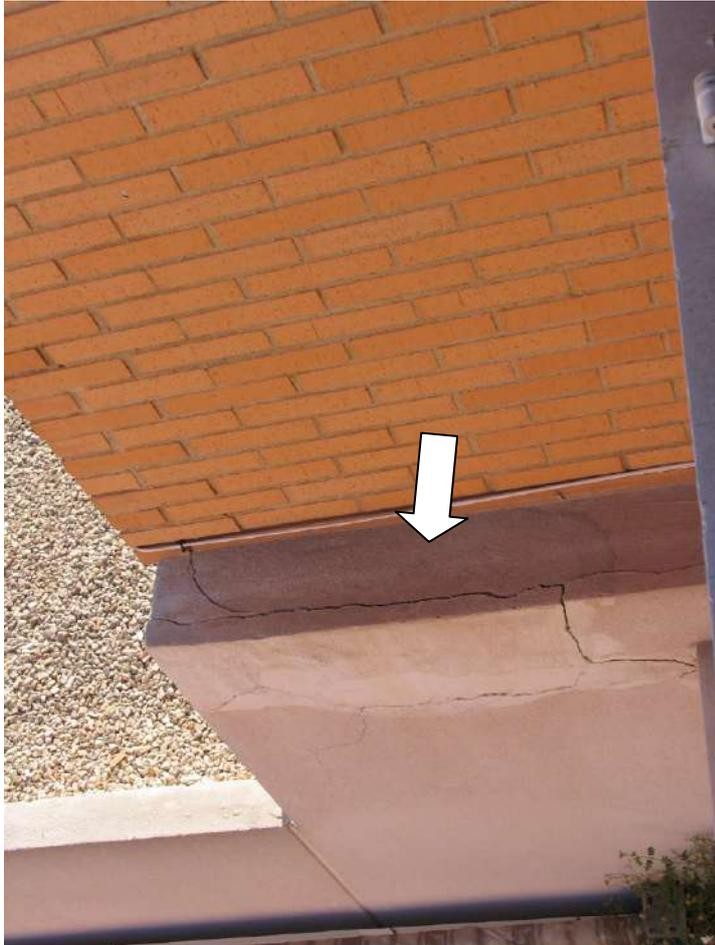
**Foto nº 25.-** Efectos producidos al interrumpirse la junta de dilatación estructural del edificio en la zona recayente a Calle .....
