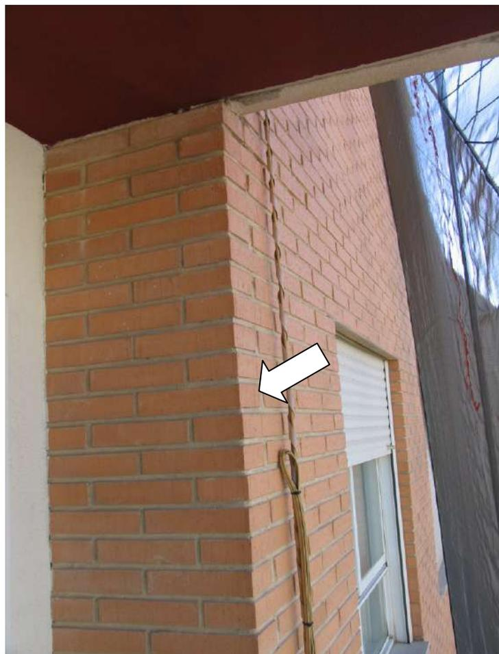
**Foto nº 12.-** Detalle de la fisura vertical junto a la esquina de la terraza del piso 3º E
