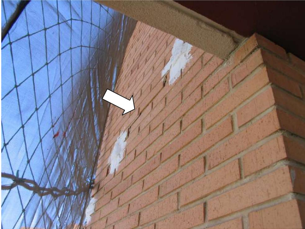
**Foto nº 11.-** Detalle actual de la grieta de la esquina con testigos de yeso para estudio de su evolución. Se observa su grueso calibre.
