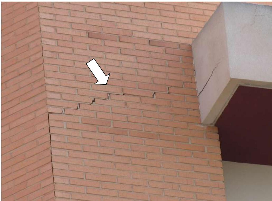
**Foto nº 10.-** Importante fisuración con amenaza de desprendimiento del muro en la esquina entre Av. .... y Calle ....., que baja desde la planta 4ª a la 3ª.
