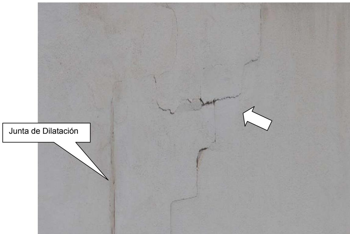
**Foto nº 32.-** Primer plano de las fotos anteriores donde se aprecia la línea de rotura escalonada producida a partir de la interrupción de la junta de dilatación.
