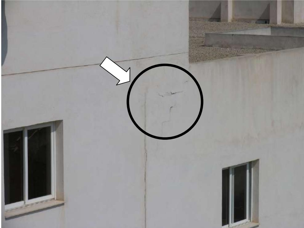
**Foto nº 31.-** Detalle de la foto anterior. Se observa como la junta de dilatación queda interrumpida.
