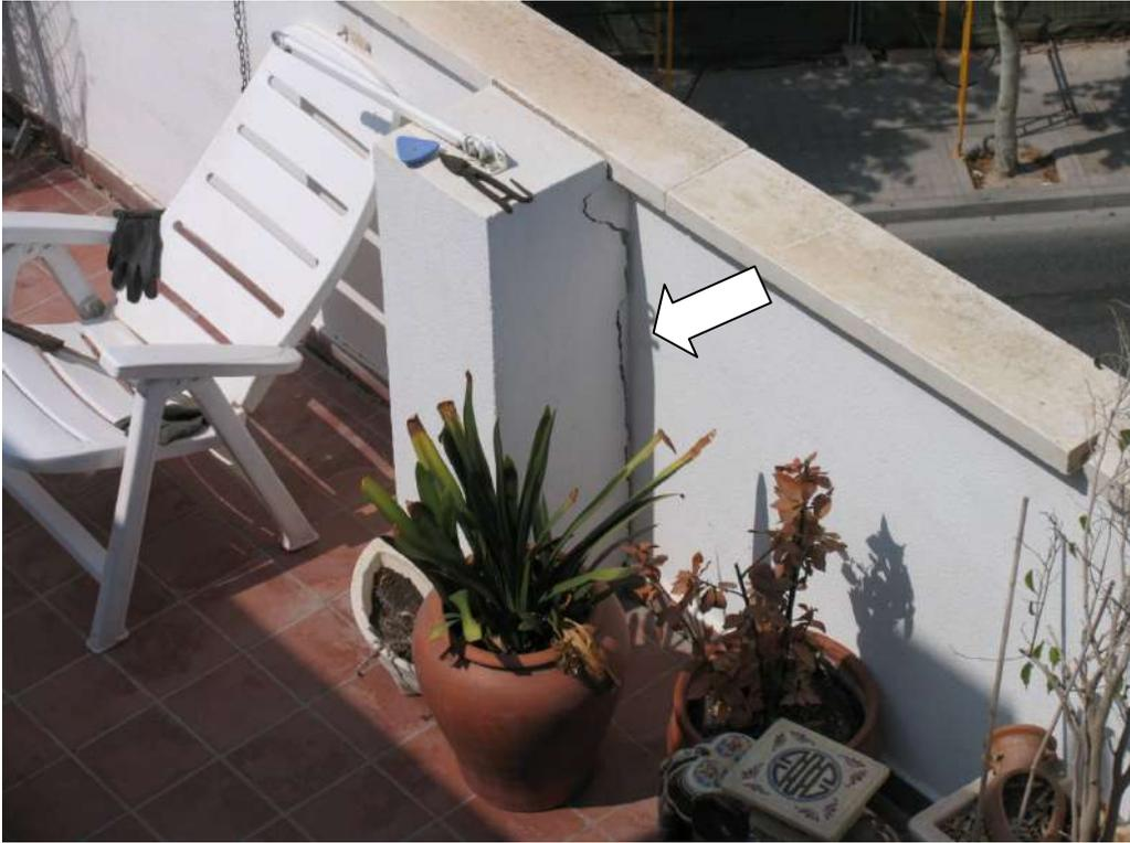
**Foto nº 19.-** Importante línea de rotura por desprendimiento de la pilastra.
