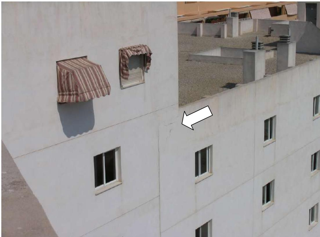
**Foto nº 30.-** Detalle de la posición de la junta de dilatación en la fachada interior.
