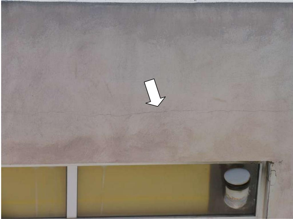
**Foto nº 35.-** Detalle de fisura horizontal en otro patio.
