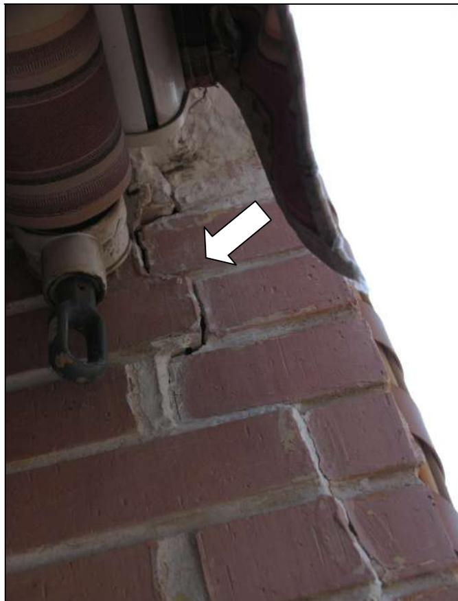
**Foto nº 8.-** Otro primer plano de la línea de rotura en la parte superior del muro
