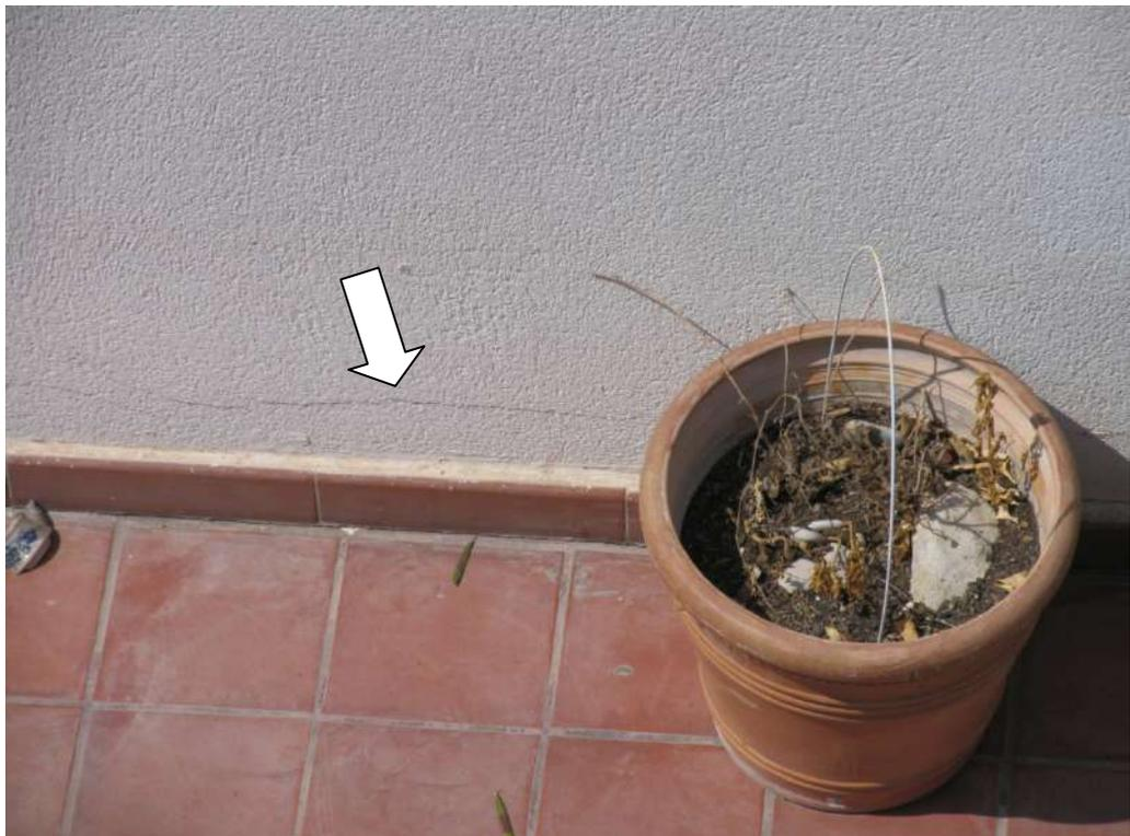
**Foto nº 22.-** Fisura horizontal sobre el rodapié.
