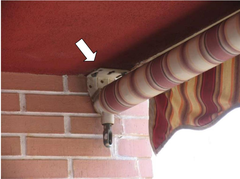
**Foto nº 9.-** Detalle del anclaje del toldo al techo
