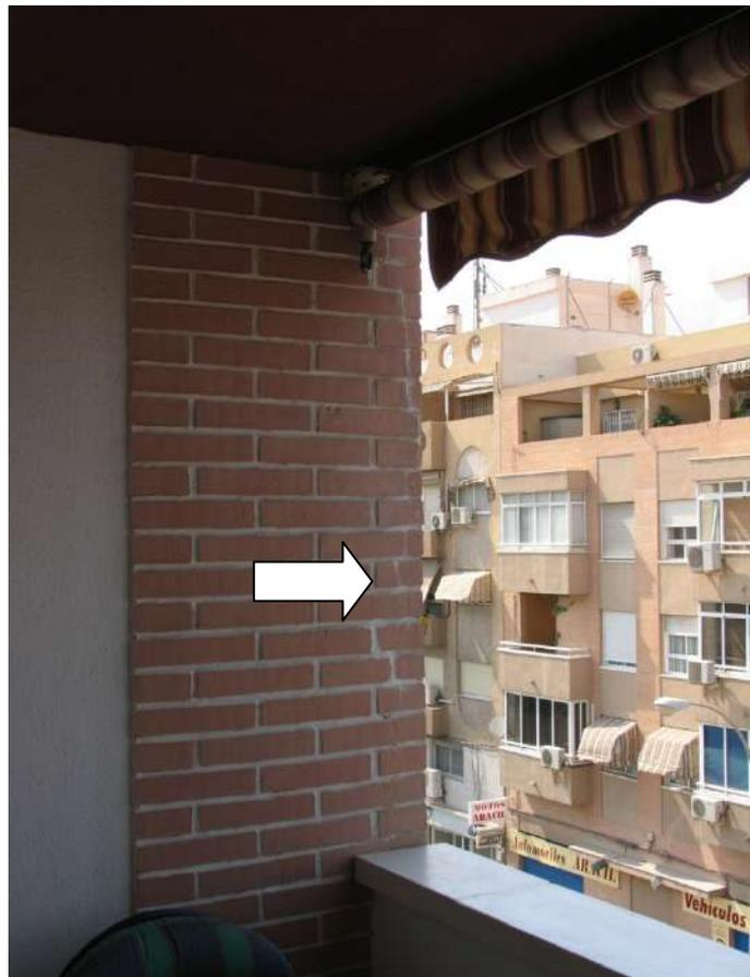
**Foto nº 6.-** Detalle de la fisura vertical en la pared medianera, vista desde la terraza de la planta 3ª.
