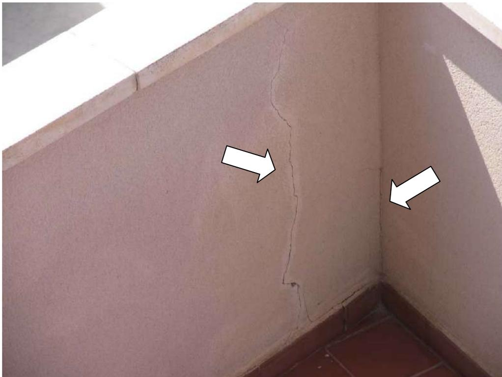
**Foto nº 18.-** Detalle interior de la esquina en la terraza del ático. Se aprecia una fisuración en el rincón, otra en una línea paralela y el desprendimiento de rodapié.
