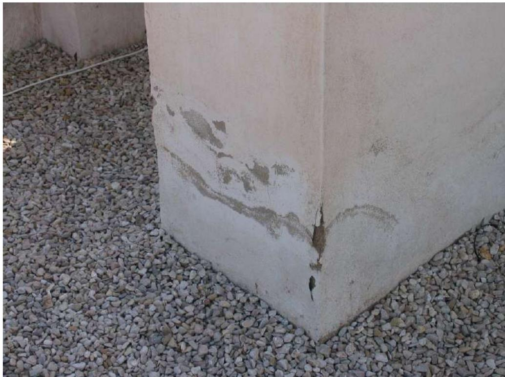
**Foto nº 40.-** Detalle de humedad ascendente por capilaridad con degradación del mortero por problemas de aguas durmientes en la base.
