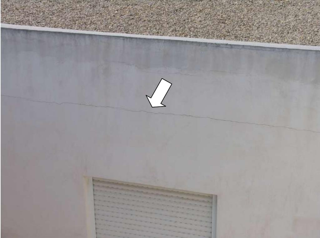
**Foto n° 33.-** Fisuras horizontales en el frente del forjado.
