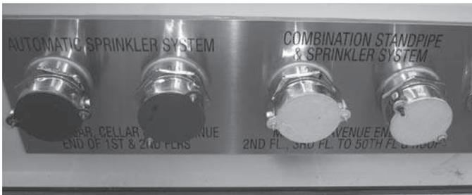
**Figura 3.** Diseño boca de riego anti-vandalismo.
