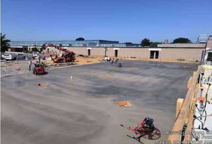
1st Floor SOG Front Half Pour
