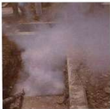
Fig. 4.3. Fumigación. Se fumigan losa y fénetro.
