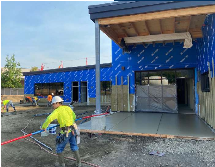
EXTERIOR SITE CONCRETE POUR
