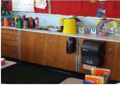
Non accessible sinks
