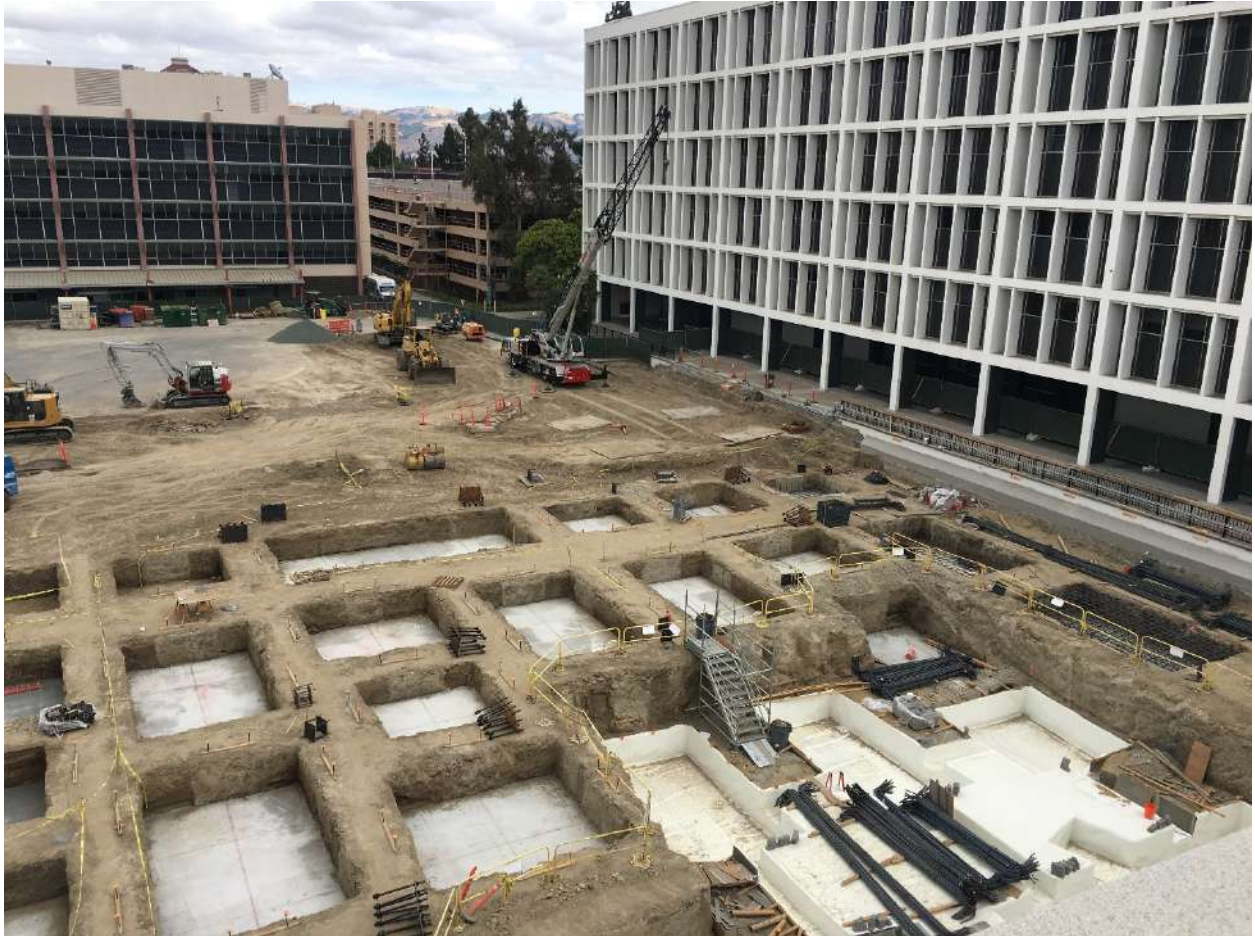
Photo: Foundation Pour After DSM Installation
